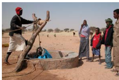
Brunnen GUERMARANE (Nachbesserung) Bauzeit: April 2008 Kosten: 650'000 CFA
