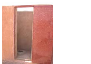
Bau der Latrinen (Zement) Bauzeit: Dezember 2005 / Januar 2006 Kosten: 4'800 CHF (2'000'000 CFA)
