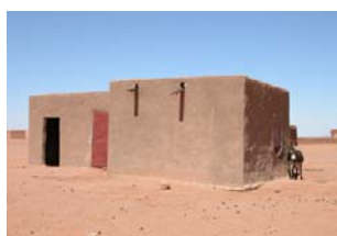
Renovierungsarbeiten Schulküche (Zementverputz) Bauzeit: April 2006 Kosten: 1'250 CHF (500'000 CFA)
