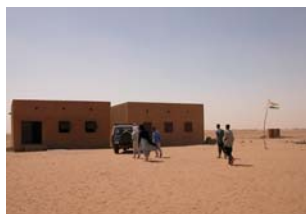
Bau des 2. Klassenzimmers (Zement) Bauzeit: Oktober - Dezember 2005 Kosten: 13'200 CHF (5'300'000 CFA)
