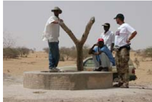
Brunnen GADAMBO Bauzeit: März / April 2006 Kosten: 15'000 CHF (6'000'000 CFA)
