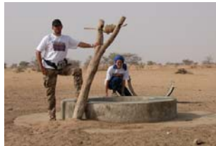
Brunnen AKAWAL 2 Bauzeit: September 2006 Kosten: 6'150 CHF (2'460'000 CFA)
